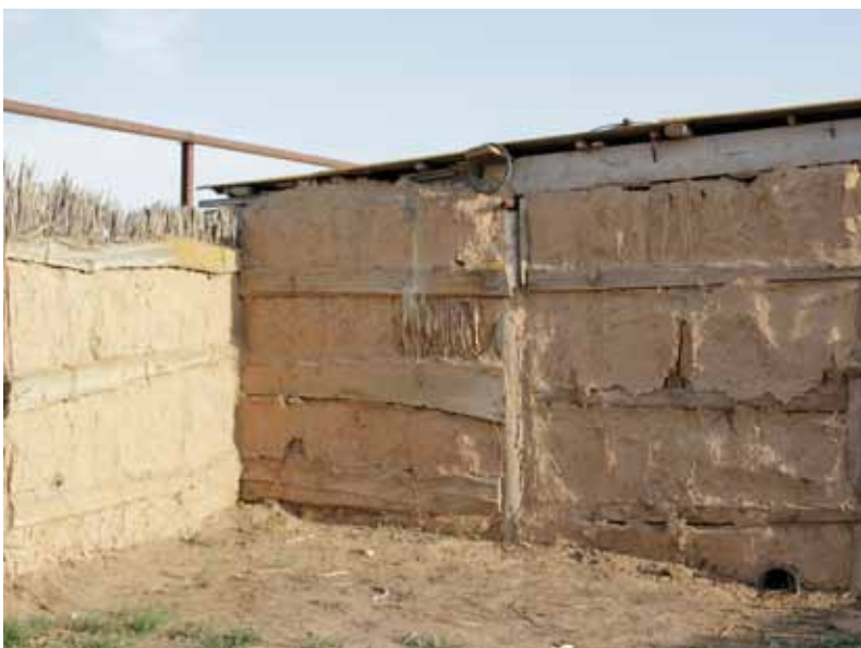
Рис. 3. Использование камыша в качестве строительного материала, аул Хан Ордасы, Западно-Казахстанская область
