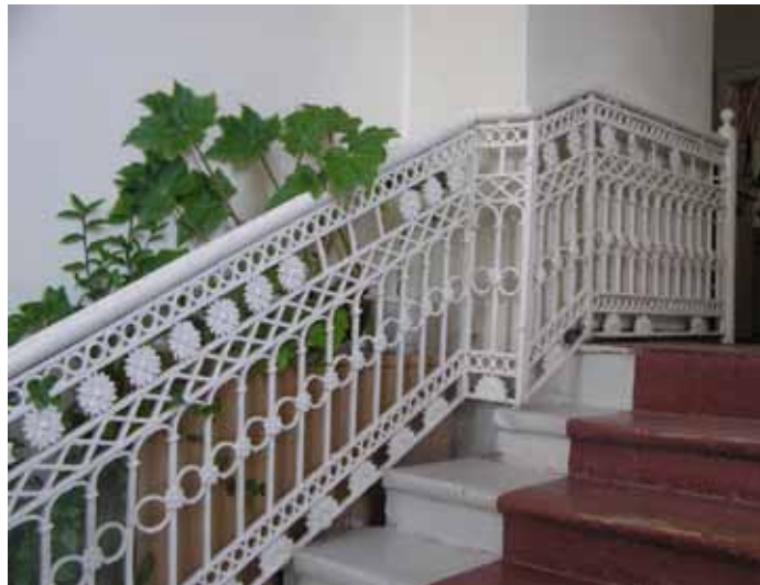
Рис. 1. Ограждение лестницы в интерьере церкви Рождества Богородицы в г. Перми
