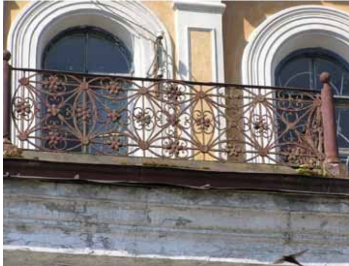
Рис. 5. Ограждение балкона особняка купца А.Г. Кузнецова в г. Кунгуре
